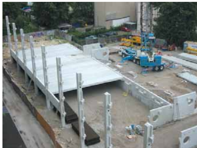
Powstałe w zakładzie prefabrykaty z betonu dostarczone na miejsce inwestycji za pomocą 200 tonowego dźwigu.
