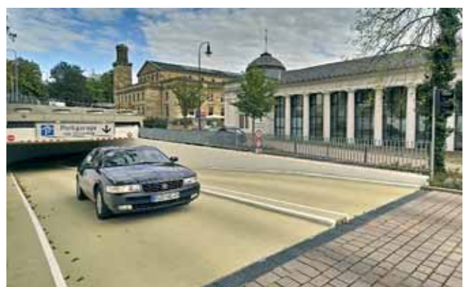
17 16,000 m 3 betonu pod ziemią
